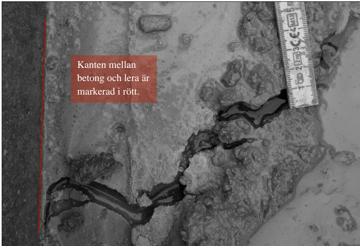
Figur 24 Exempel på en spricka i leran utmed plattans kant.
