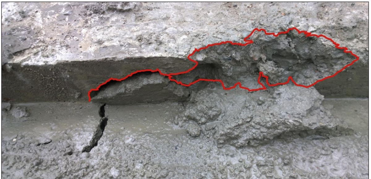
Figur 26. Leran går upp i betongplattan, brottet har gått i leran. Till höger i bild har leran och betongen blandat sig och vilket ger att denna del kollapsat.
