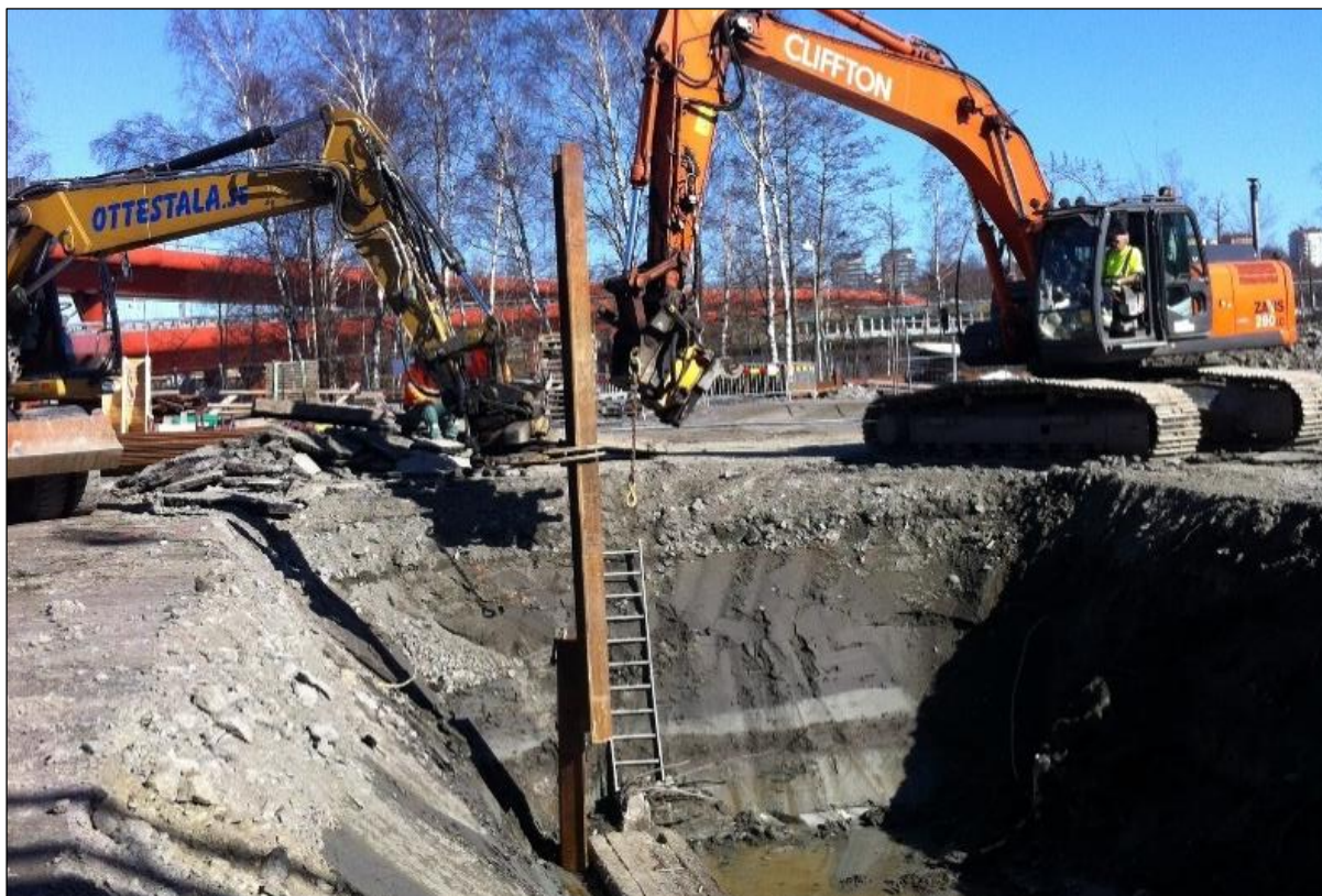
Figur 10. I bild sätts sponten på plats.
