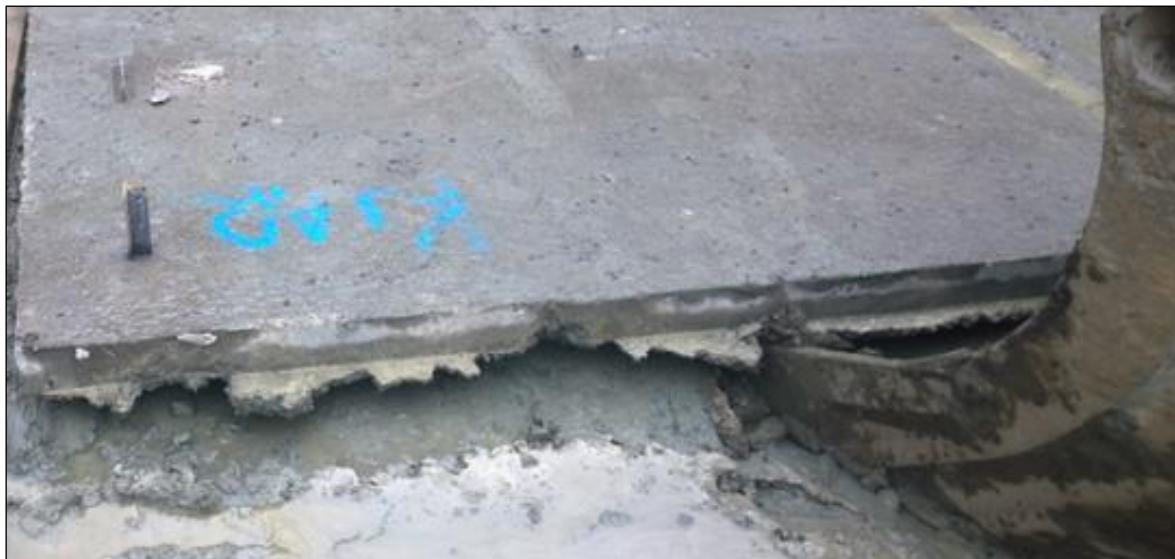
Figur 27. I bild framgår att betongen har flutit ut på sidorna av plattan.
