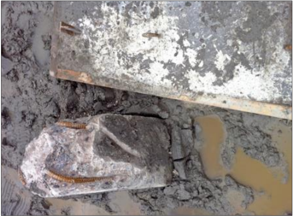
Figur 29. Pålen som stack upp precis bredvid krypförsöksplattan.
