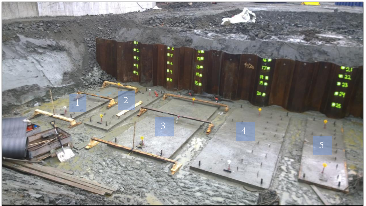
Figur 12 Färdiggjutna plattor i botten på schakten, med respektive numrering i den blå rutan på varje platta.
